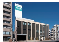
三篠礼会館 広島県広島市
