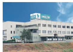
福山礼会館 広島県福山市
