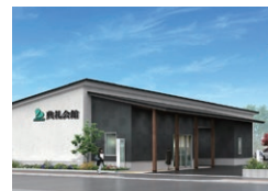
石巻典礼会館 宮城県石巻市
