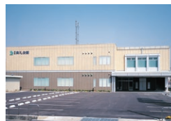
福山東礼会館 広島県福山市
