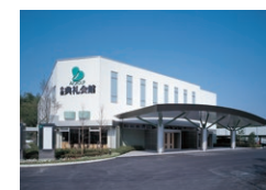
小嶺典礼会館 福岡県北九州市
