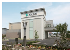
堺西典礼会館 大阪府堺市
