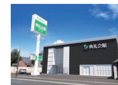
行橋典礼会館 福岡県行橋市
