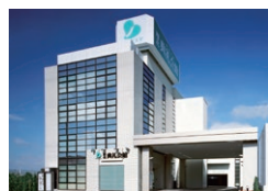
堺北典礼会館 大阪府堺市
