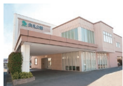
岩国南礼会館 山口県岩国市
