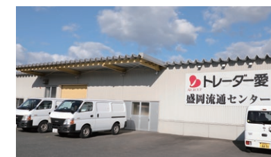
盛岡流通センター(トレーダー愛) 岩手県紫波市
