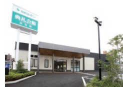
安佐南礼会館 広島県広島市
