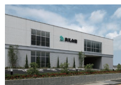
橋本典礼会館 福岡県福岡市
